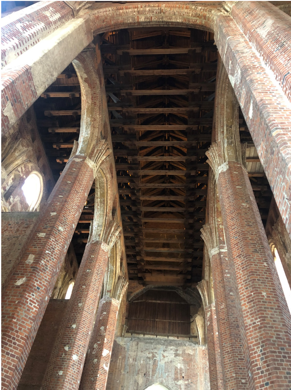
Foto: Blick in den Dachraum St.-Marienkirche, Beeskow
